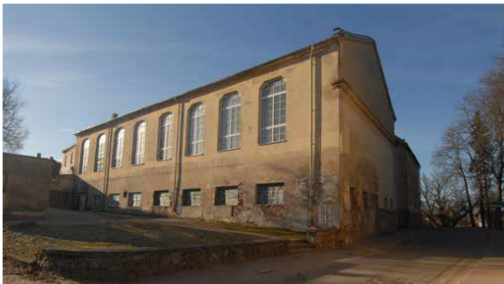
13. att. Ēka, kas atradās vietā, kur tagad izbūvēta ar vēsturisko biedrības namu savienota piebūve peldbaseinam
