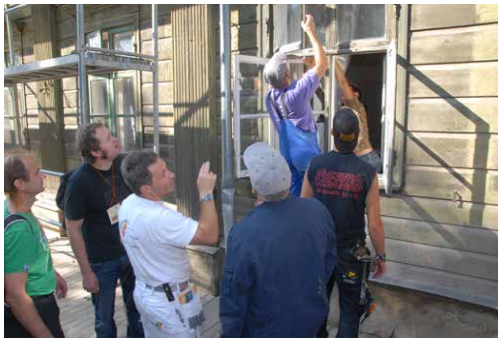
6. att. Starptautiskā koka restaurācijas nometne — koka fasādes un apdares detaļu atjaunošana dzīvojamai ēkai 1905. gada ielā
