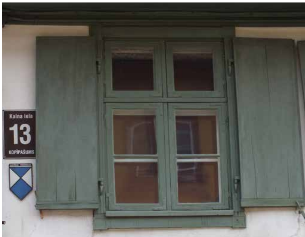
4. att. Atjaunotie būvgaldniecības elementi ēkās Kalna ielā 15 un Kalna ielā 13
